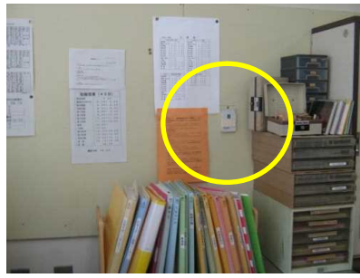
保健室（5） 窓近くの壁（小会議室側）の ケースの陰
