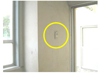
B棟昇降口（6） B棟渡りの柱のところ
