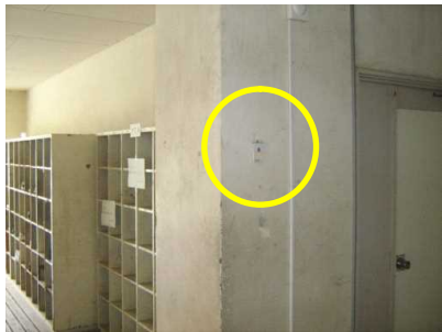
C棟昇降口（7） 1年下駄箱の脇の柱
