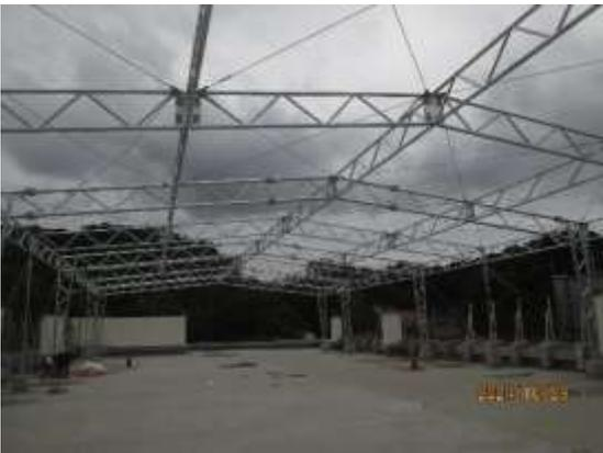
屋上の防球ネットの完成が間近となりました。校舎の建て替えに伴い、校庭の使用が制限されるため、児童の活動場所として屋上を利用するための工事です。写真にある鉄骨にネットをかけて完成となります。
